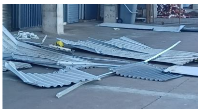
Imatge 12. Desperfectes ocasionats pel temporal de 28/02/2023 amb despreniment de les xapes de revestiment i arrencament de seccions de la coberta sandvitx insitu.
