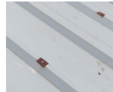
Imatge 08. Imatge dels ancoratges del panell sandvitx i la canal extrem mar.
