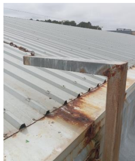
Imatge 06. Imatge de les cobertes planes i trobaments amb patologies de corrosió i infiltracions.
