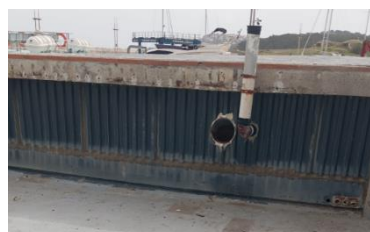
Imatge 06. Imatge de les cobertes planes i trobaments amb patologies de corrosió i infiltracions.
