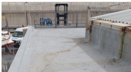
Imatge 06. Imatge de les cobertes planes i trobaments amb patologies de corrosió i infiltracions.
