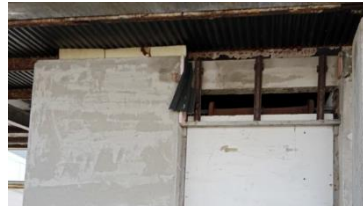
Imatge 07. Imatge de la xapa inferior del panell sandvitx on s'observa la degradació dels ancoratges, així com de la pròpia xapa en el recolzament amb les corretges.
