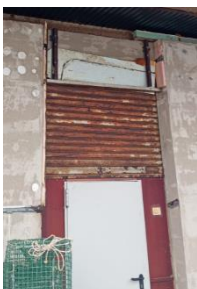
Imatge 12. Desperfectes ocasionats pel temporal de 28/02/2023 amb despreniment de les xapes de revestiment i arrencament de seccions de la coberta sandvitx insitu.
